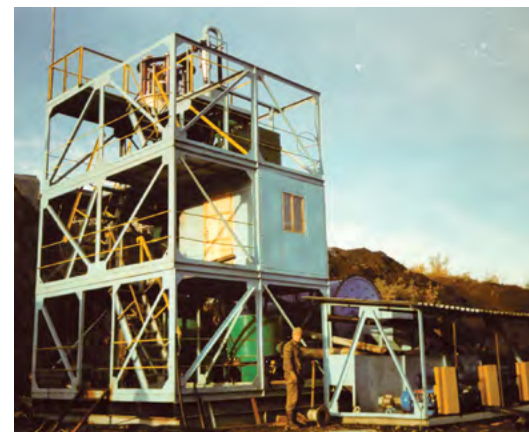
Монтаж модульной фабрики на месторождении Мальдяк
