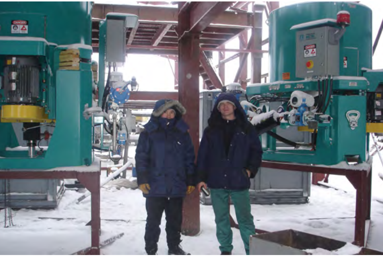
Монтаж в зимних условиях
